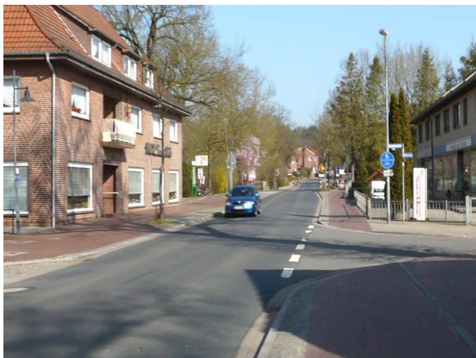
Bild 3 L213 – Brückenstraße Einmündung Moorweg Richtung Bendestorf Ende des kombinierten Geh- und Radwegs
