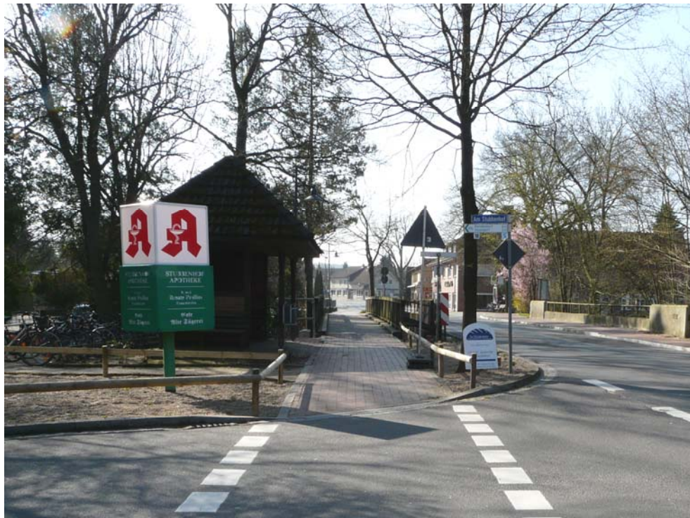
Bild 5 L213 – Brückenstraße Am Stubbenhof Richtung Asendorf Radwegmarkierung entlang Gehweg, schmaler Straßenraum im Brückenbereich
