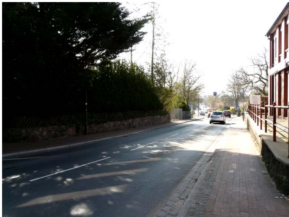
Bild 6 L213 – Brückenstraße Richtung Asendorf Enge Fahrbahn und schmale Gehwege
