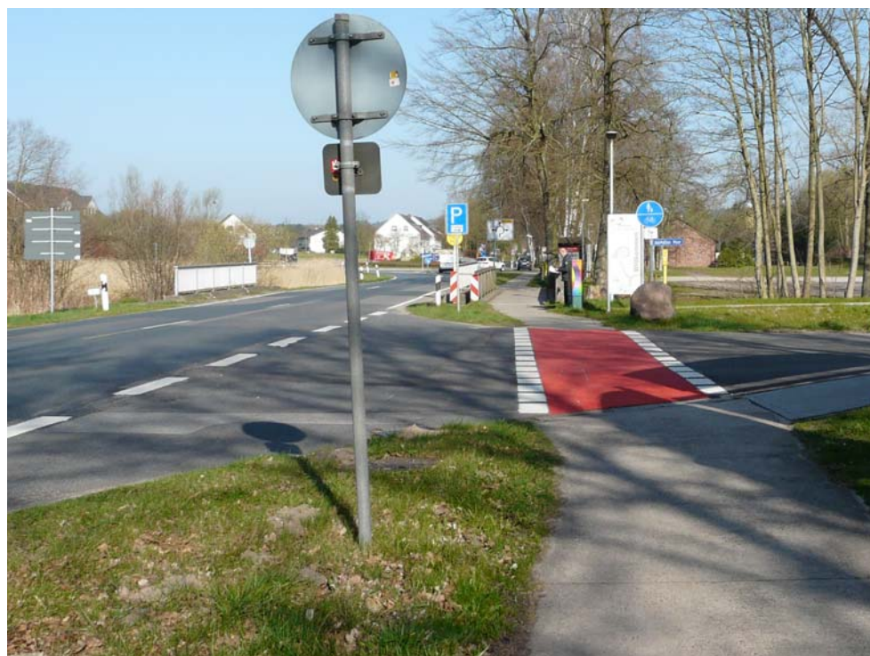
Bild 2 L213 – Schützenstraße Ortsende Richtung Bendestorf Kombinierter Zweirichtungs-Geh- und Radweg, Hervorhebung der Radfahrerfurt
