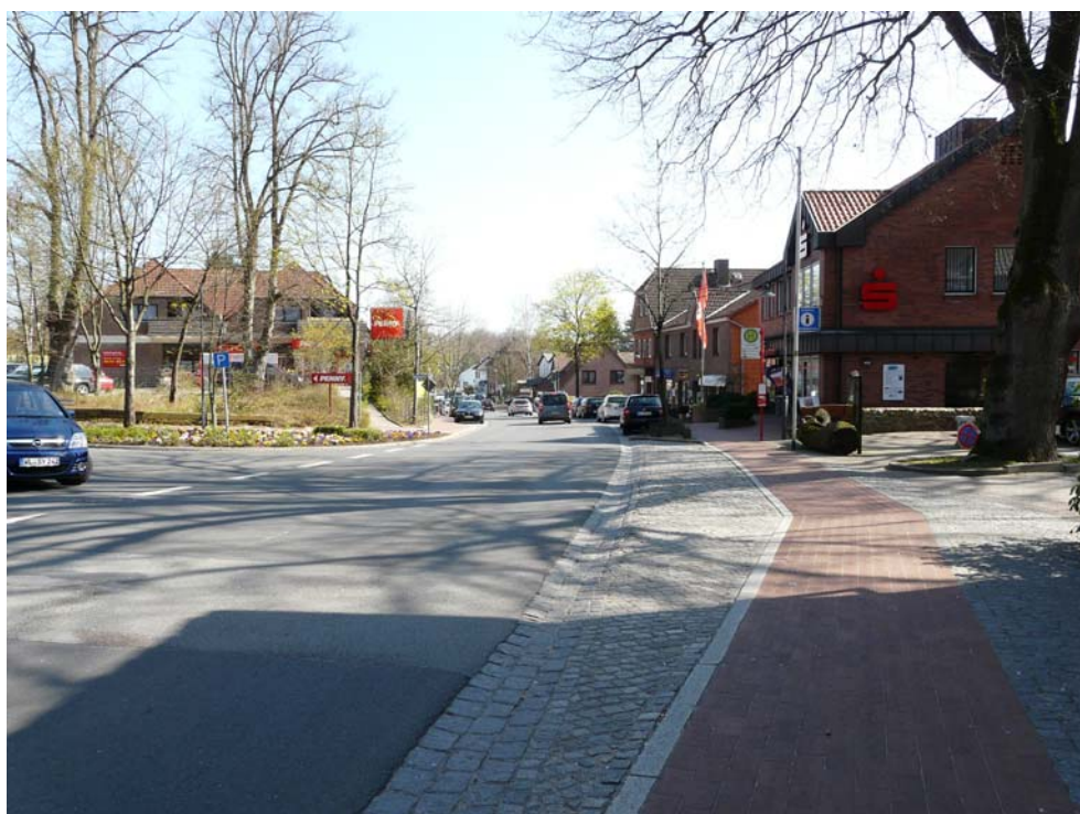
Bild 19 L213 – Hauptstraße Richtung Asendorf Durchgehender Gehweg, kein Parken
