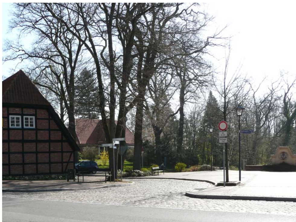
Bild 14 L213 – Hauptstraße, Spethmannplatz Verbot der Einfahrt, Weiterführung von Radwegweisung und Radweg
