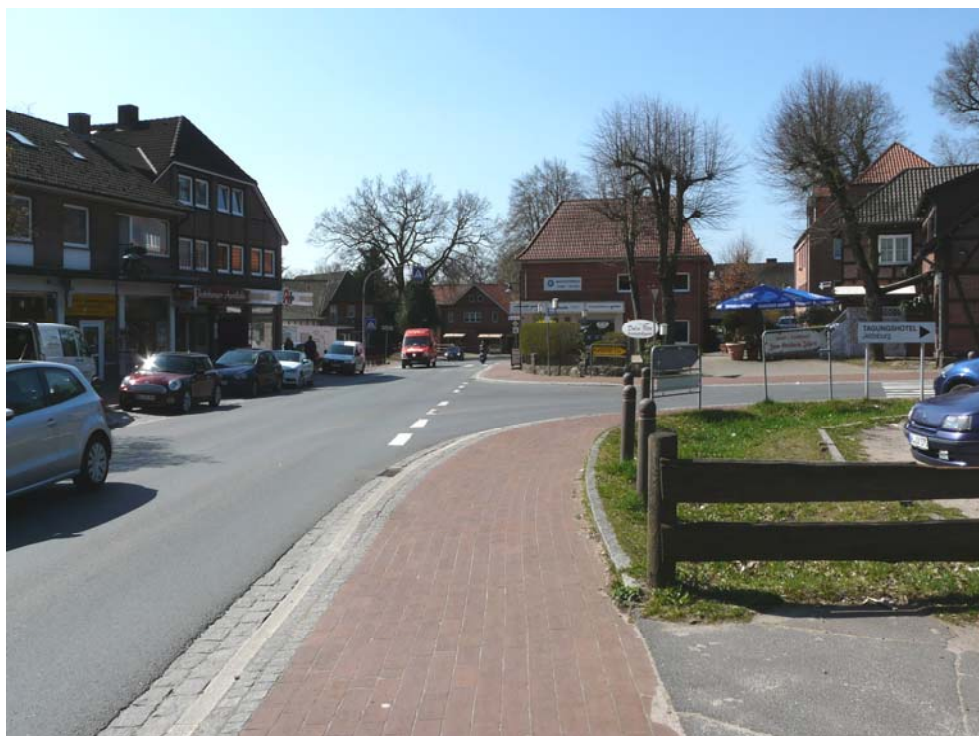
Bild 11 L213 – Hauptstraße Richtung Asendorf Einmündung Itzenbütteler Straße
